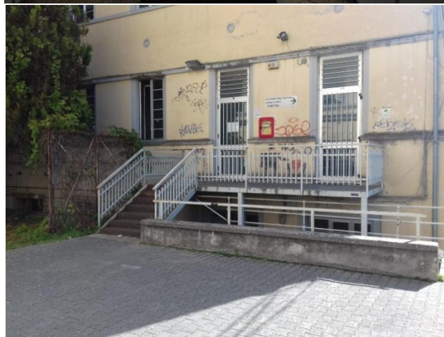
VISUALE INTERNA ED ESTERNA USCITA EMERGENZA N.3
