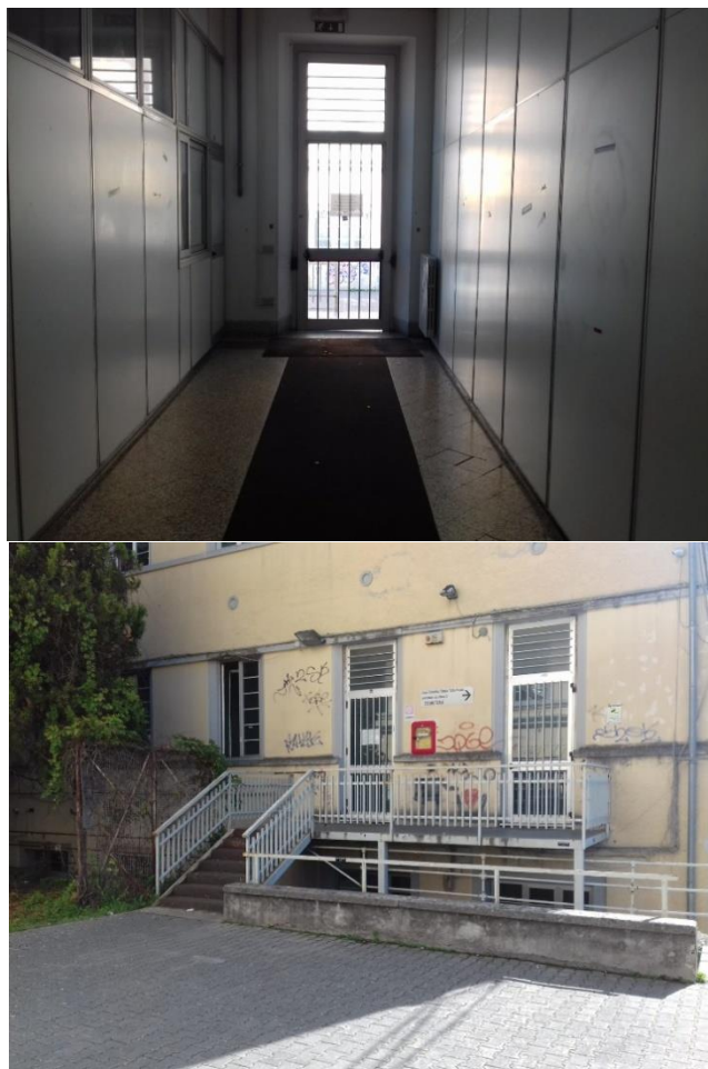
VISUALE INTERNA ED ESTERNA USCITA EMERGENZA N.3
