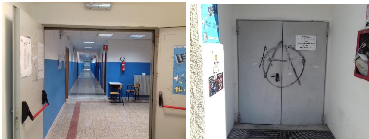
VISUALE INTERNA ED ESTERNA USCITA EMERGENZA N.1
